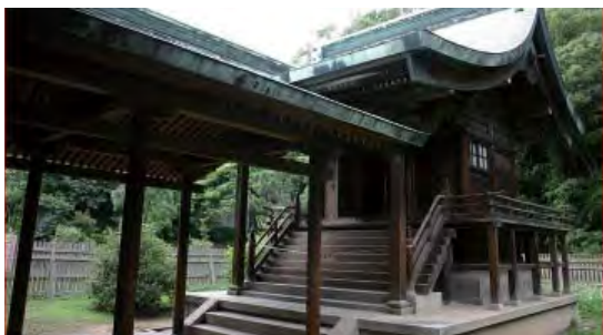
回廊と欄干にかこまれた神殿は木組みの台座上に鎮座している。いわゆる高床式の構造で、風通しがよく、虫食い防止にも効果がある。日本統治時代の神社の中で、完璧な姿で残っているのは桃園神社だけだ
