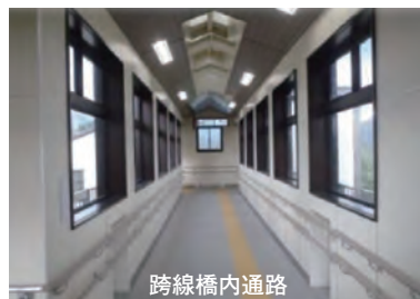
JR東日本 平泉駅(エレベーター設置、跨線(こせん)橋新設)
