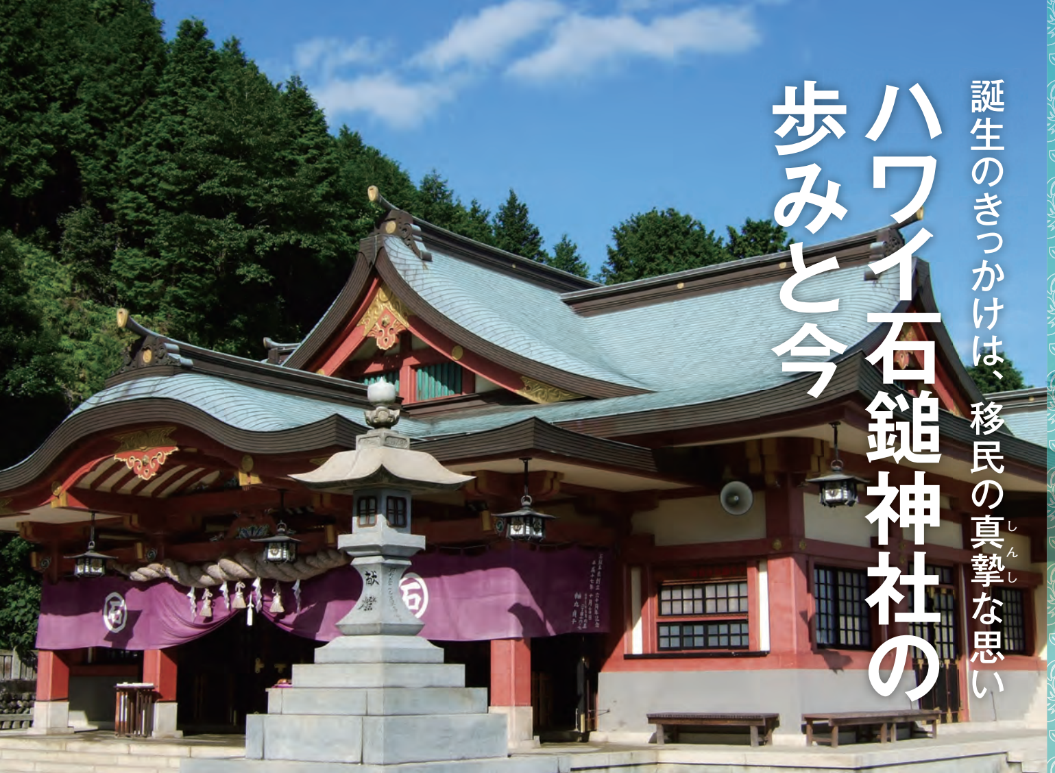
石鎚神社口之宮本社の本殿。平成27年秋まで、平成の大改修が行われている。
