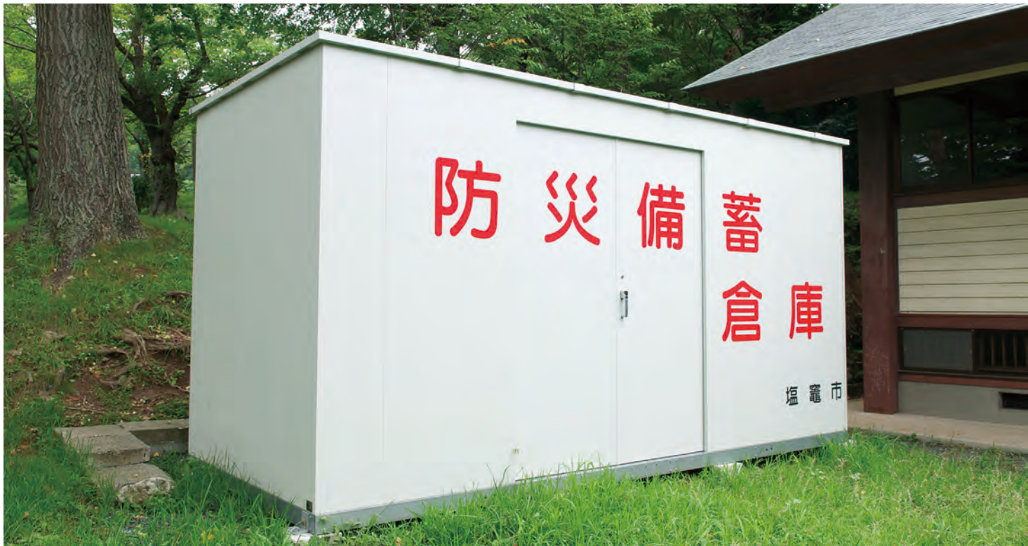
志波彦神社・鹽竈神社の境内に設置された備蓄倉庫
