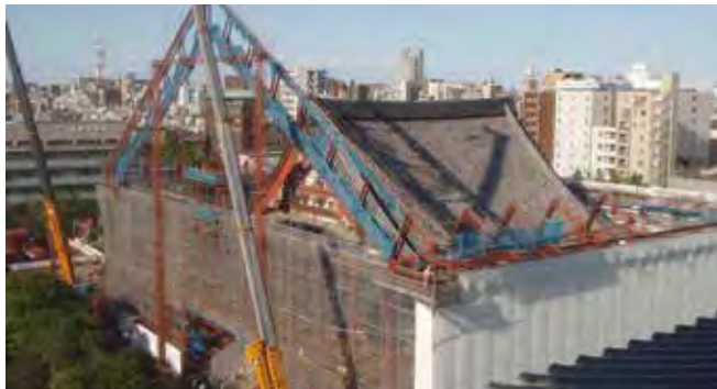
(右上) 本瓦葺からチタン瓦葺に改修された浅草寺本堂 (右下) 浅草寺本堂素屋根トラス架設工事の様子 (左上) 免震化が行われた西新井大師総持寺本堂 (左下) 西新井大師総持寺の1階柱頭に設置された免震装置は、地震時に変形し、建物に直接作用する地震力を低減
