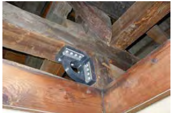
(右) 柱と梁の仕口部分に取り付けることによって、振動エネルギーを吸収する樹脂ダンパー（樹脂一体型仕口ダンパー耐震リング）(中) 柱や梁を補強するリブフレームという枠組み (左) 西教寺耐震改修工事の設計図面
