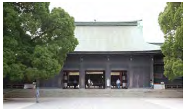
（上）耐震改修工事前の明治神宮 外拝殿 （下）施工中の外拝殿。仮囲いに特殊デザインシートを使用し、工事中とは思えない雰囲気と環境を維持した
