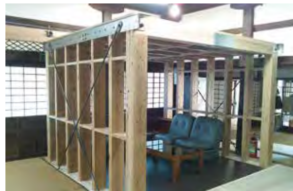
(右上) (右下) 耐震工事前や工事中も安心して行事を執り行えるよう、仮補強として「耐震シェルター」を4箇所を設置 (上)「耐震シェルター」で使用した木材は塗装して再利用される
