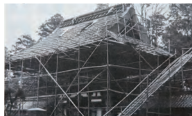
楼門の屋根葺き替え工事にかかった昭和50年頃
