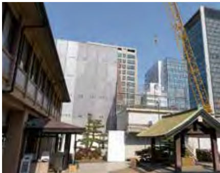
建て替え工事の様子
