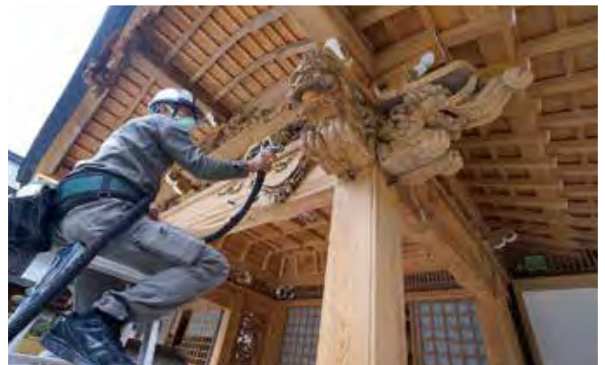
『エコポロン』施工の様子
