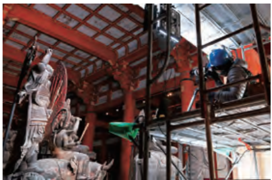
東寺講堂内に足場を組み、立体形状計測と高精細撮影で、21尊をデジタルアーカイブしていく
