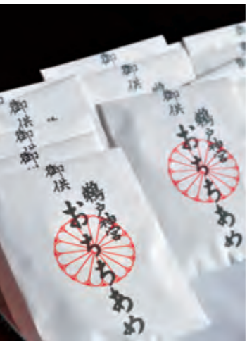
上／洞窟内に建つ朱塗りの本殿。屋根を銅板で保護しているが、塩害と湿気の対策が急務。しかし県指定文化財であるため、新たな技術の導入などが課題となっている。 下／伝承にある「お乳岩」が本殿裏に。そこから滴り落ちる水でつくった「おちちあめ」も古くから知られた授与品
