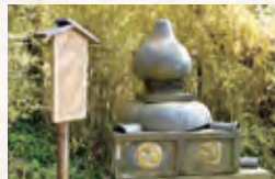
1985年、社殿の屋根は、重く建物に負担のかかる瓦からステンレスへと変更。変更前の瓦の宝珠が今も境内に残る
