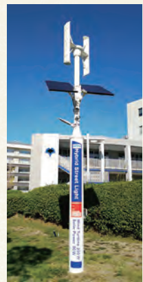
大阪大学吹田キャンパスの設置された独立電源通信網「みまもりロボくんⅢ」。(一社)全国自治会活動支援ネットワークの発案で、NTN社が筐体を提供し、稲場教授の研究グループが共同で開発を進めている
