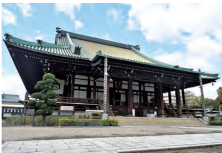
本堂の大屋根に圧倒される境内。山門をくぐった先の境内は、すべての人がひとつになれる空間である。近隣住民が掃除や草むしりに訪れるなど、地域から大切にされている
